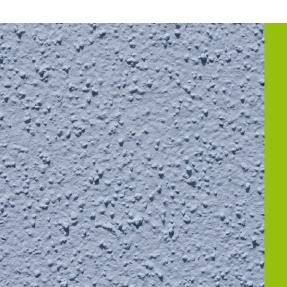
Hochwertige Außenputze und -farben schützen Wände vor eindringendem Wasser und verhindern dadurch, dass Kohlendioxid und Salze die Materialstrukturen des Betons angreifen.
